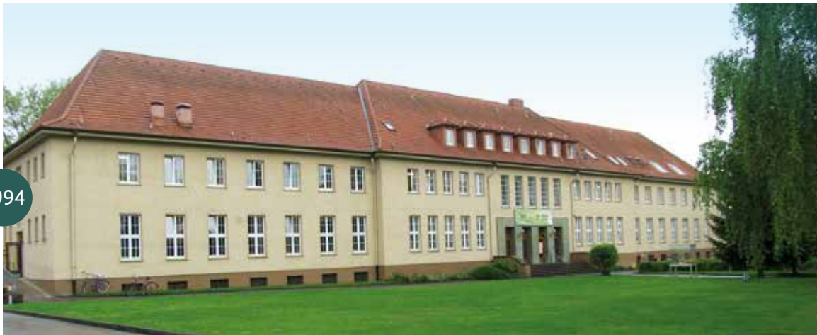
Die Gesamtschule bezieht die ehemaligen Kasernen in der Georgstraße.
